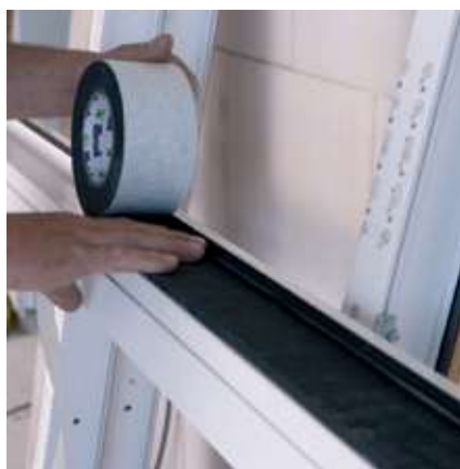
Aplikácia TP652 na rám okna. Jednoducho, rýchlo a čisto.
